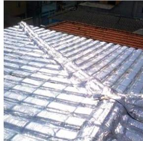
3. Impermeabilização do telhado sob as telhas: a terceira opção analisada é a impermeabilização do telhado com a aplicação de manta asfáltica aluminizada sob as telhas existentes. Essa metodologia consiste na remoção das telhas, aplicação da manta asfáltica sob as telhas existentes e posteriormente a instalação de telhas novas, conforme planilha abaixo.
