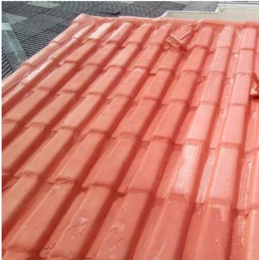
Analisando os pontos apresentados acima e os orçamentos realizados, entende-se que a utilização da opção 4, impermeabilização do telhado com borracha líquida é a opção mais indicada para o local. Para isso, será necessária a contratação do material, sendo o serviço realizado pelas equipes de manutenção civil contratadas através do contrato 068/2023.
